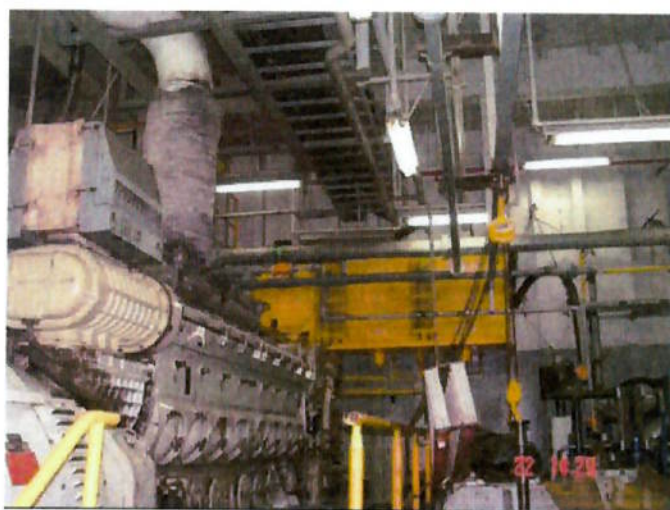
Figura 10 – Parede da sala de geradores.
