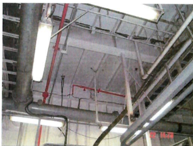
Figura 9 – Teto da sala de geradores.
